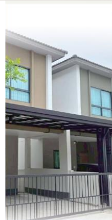
ต่อเติมโรงจอดรถ
